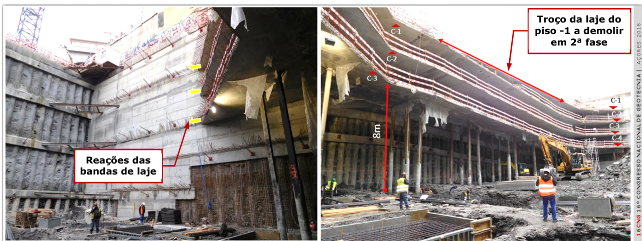
Figura 9 – Vista dos trabalhos junto ao alçado GA (à esquerda) e alçado AB (à direita) em fevereiro de 2017
