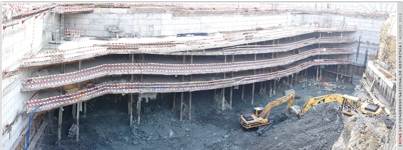
Figura 8 – Vista da totalidade das bandas de laje em dezembro de 2016
