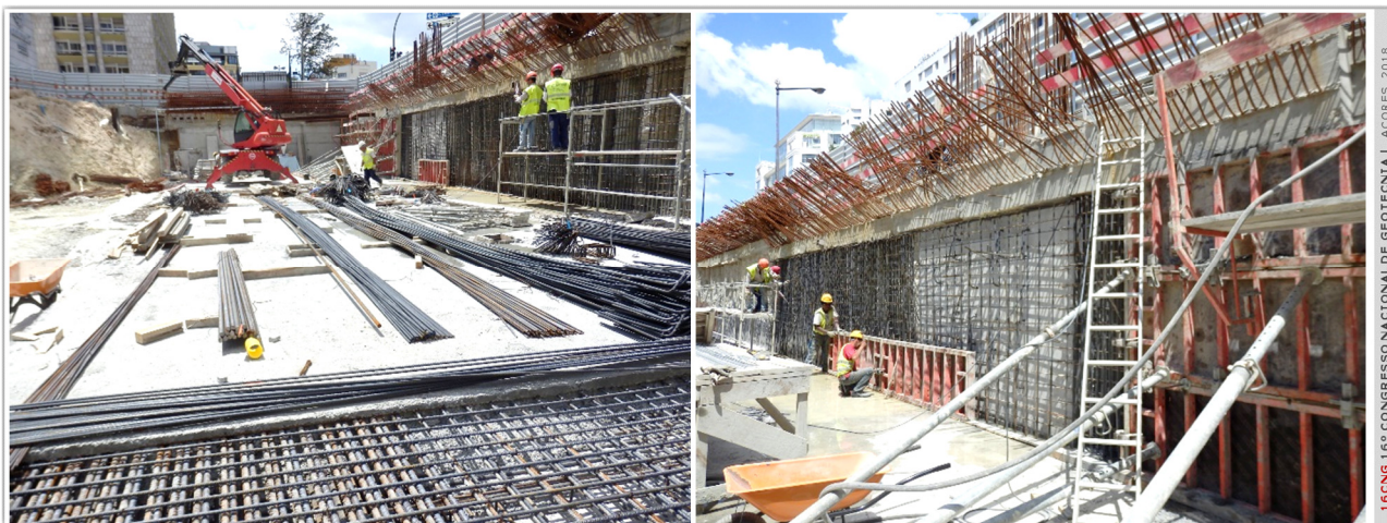
Figura 7 – Vista dos trabalhos de reforço no alçado AB em junho de 2016: banda de laje horizontal (à esquerda) e parede de revestimento da cortina de estacas (à direita)
