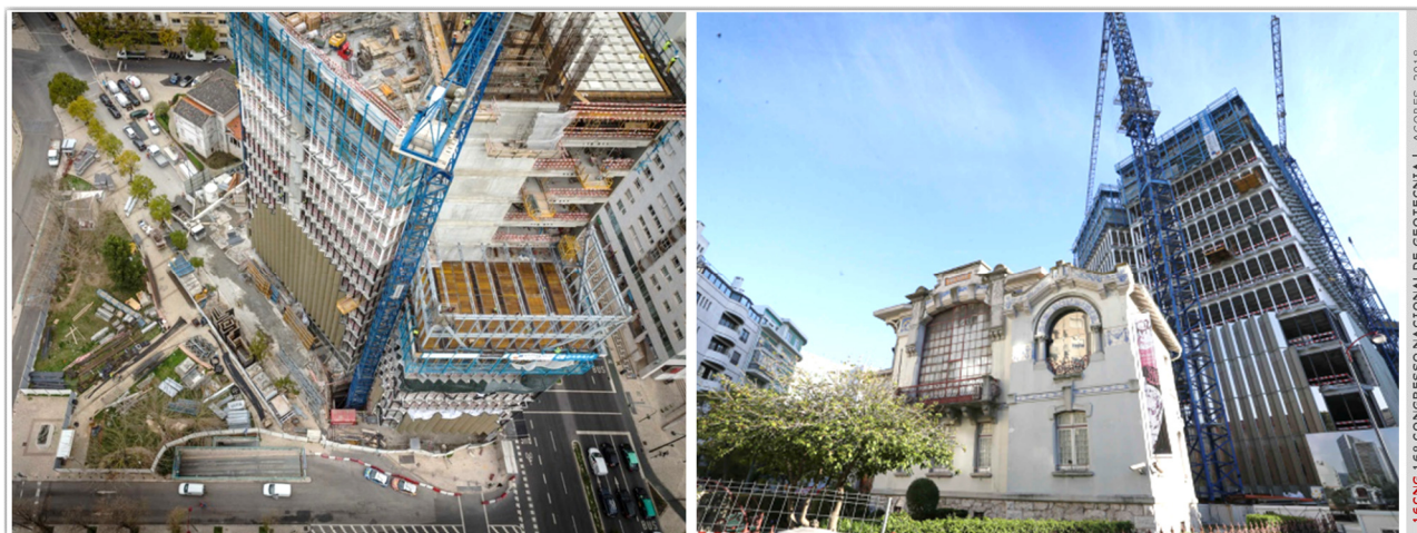
Figura 12 – Vistas da obra no início de 2018
